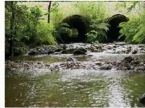
”Pienten kynnysten rakentaminen rumpun alapuolelle nostaa veden pintaa ja luopuu esteistä, josta kalat saavat uusia liikkumisen rumpua.” © Elina Erkilä / WWF
